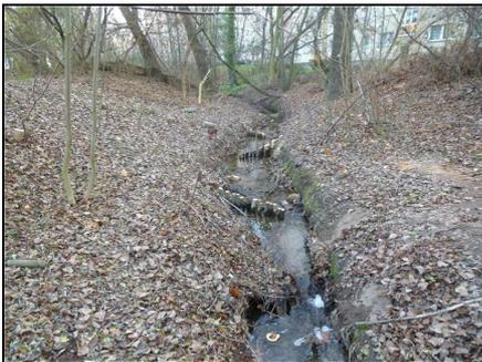
Abb. 4: Nach der Maßnahme: Initiierung von Breiten- und Tiefenvarianz durch strömunglenkende Buhnen, 16.12.2020
