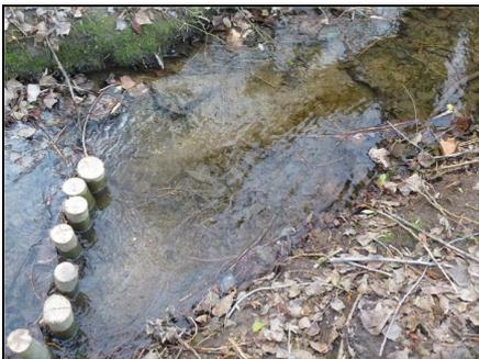
Abb. 5: Nach der Maßnahme: Substratsortierung durch Strömungsvarianz an den Buhnen, 16.12.2020
